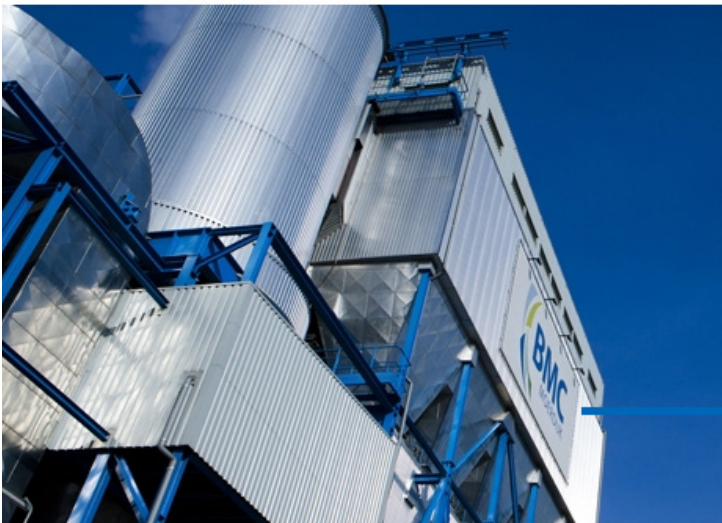
Biomasse Heizkraftwerk BMC Moerdijk
