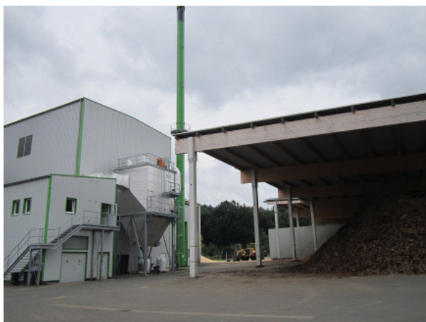
Biomassekraftwerk in Hosenfeld
