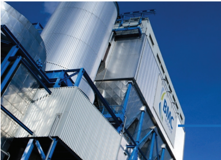
Biomasse Heizkraftwerk BMC Moerdijk
