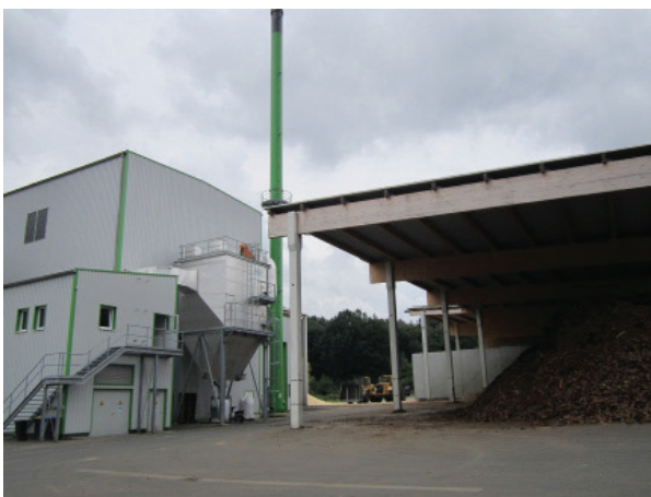
Biomassekraftwerk in Hosenfeld
