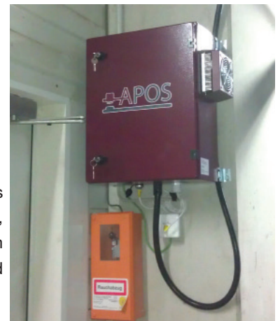
CSU im Einbau
